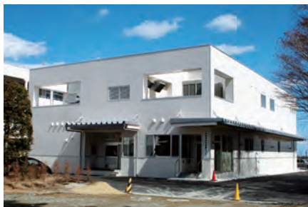
▲完成した学校給食センター(H23年3月)
